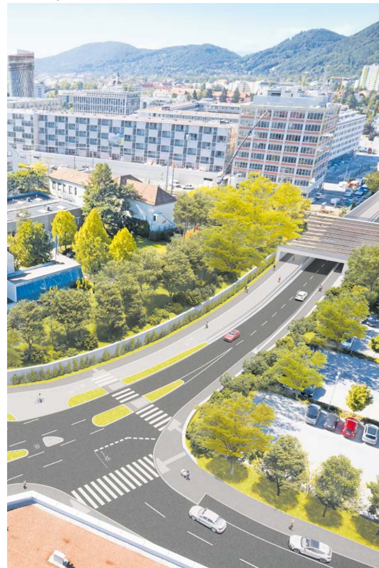
Zug um Zug. Die ÖBB erneuern ab 15. Jänner die Eisenbahnbrücke über der Peter-Tunner-Gasse. Das bringt auch ein Plus für aktive Mobilität.
