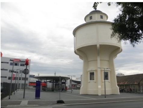
Vorplatz und Abgang Waagner-Biro-Straße
