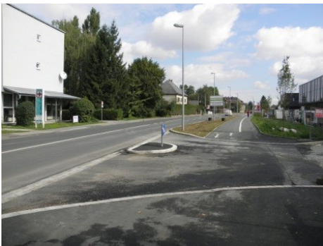
Peter-Rosegger-Straße, Zufahrt Neu und neu gestalteter Südteil
