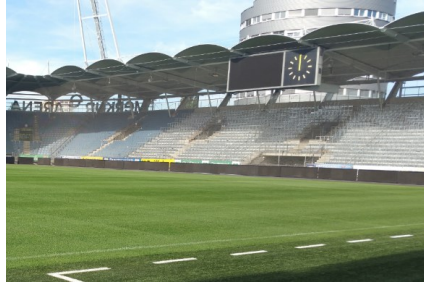
Umbau d. Tribüne in Stehplatzsektor
