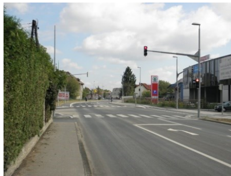
Peter-Rosegger-Straße, neu errichtete Kreuzung, Blickrichtung Osten
