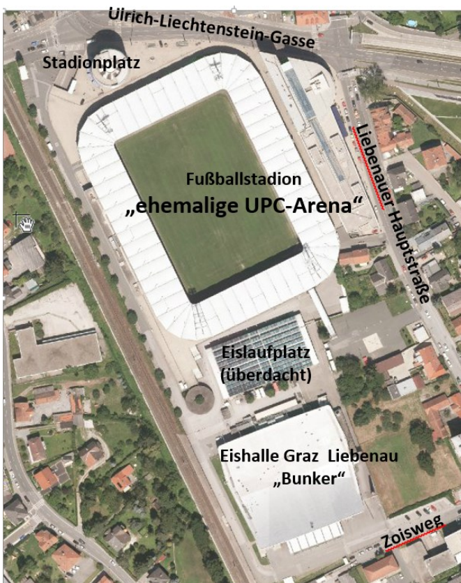
Luftbild - Eishalle Graz Liebenau, überdachter Eislaufplatz und ehemalige UPC-Arena Quelle: Geodaten Stadt Graz; Einträge StRH
