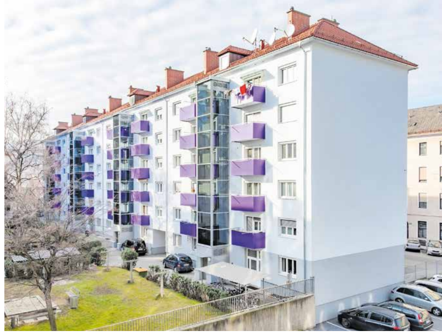
Dach- und Fassadenbegrünungen werden das Stadtbild in Zukunft prägen. Zeitgleich setzt die Stadt auf thermische Sanierungen wie zum Beispiel in der Wohnanlage in der Grazer Ghegagasse (Bild oben).
