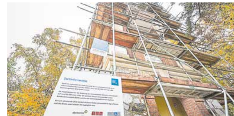
MARIATROST Die Stefanienwarte auf der Platte wird saniert und sorgt bald wieder für gute Aussichten.
