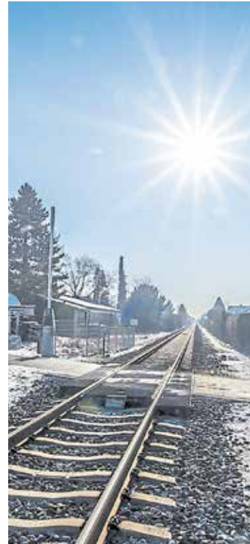
STRASSGANG Nach erfolgreichen Interventionen wurde der Bahnübergang Trattfelderstraße doch nicht geschlossen.
