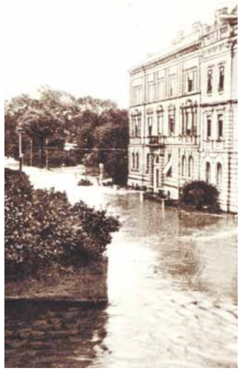
Die überflutete Schillerstraße am 16.6.1913 mit den Häusern Nr. 35 und 36
